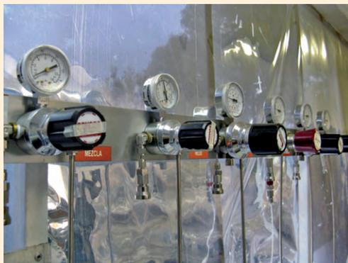
**IMAGEN 5.** Detalle de los puntos de uso de gases, instalado en el LMN del CCADET.
